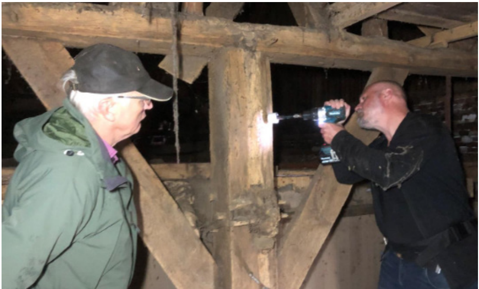
Harrie Austie kijkt aandachtig toe hoe Sjoerd van Daalen met de holle boor een gebintstijl bemonsterd.
